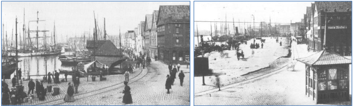
Figur 6 Tyskebryggen sett fra nordre del av Torget, før og etter bygging av ny kai på strekningen Torget-Nicolaikirkealmening. Legg merke til nivåforskjell mellom det gamle og det nye kaiplanet (Fossen 1984:76).
